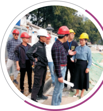
项目现场检查 花都区石岗商业楼
