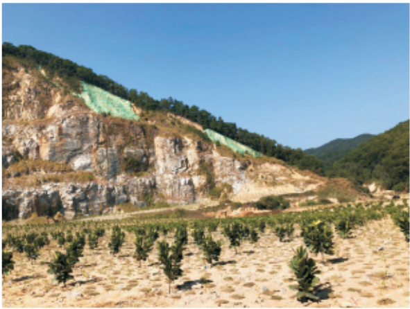
▲增城区恒发石场矿山复绿工程
