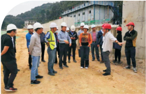
▲牛路水库建设工程现场检查
