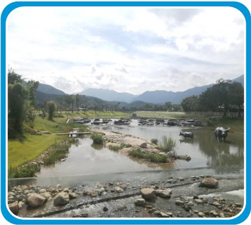
从化区良口镇鸭洞河治理工程
