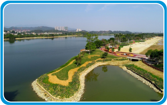
增城区增江“一江两岸”水利综合整治工程
